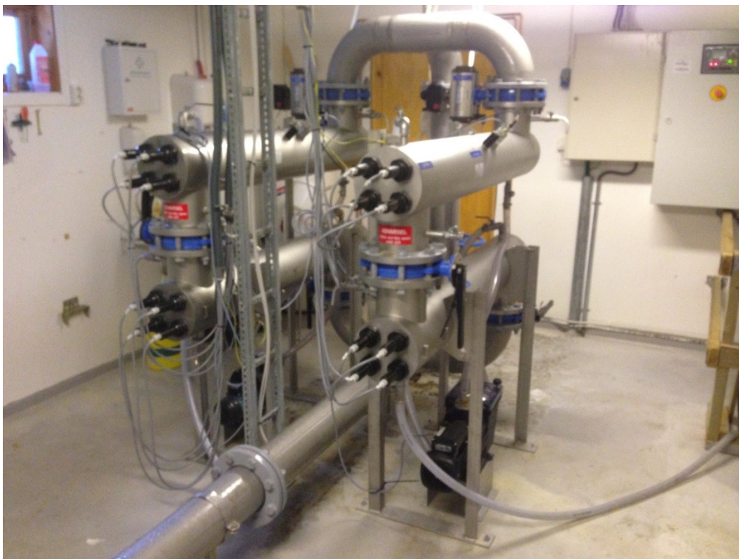
Bilde 4-1 , viser UV-aggregatet på Reipå som er fra 2010 (Unik Filtersystem).
