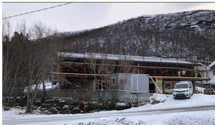
Ny bolig under oppføring, Åsveien 20
