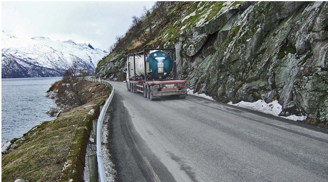
I 2011 ble reguleringsplanen for utbedring av fylkesvei 17 Glombergan-Setvikdalen vedtatt. Det er forventet at utbedringsarbeidet kommer i gang i løpet av få år. Foto: Trond Skoglund.
