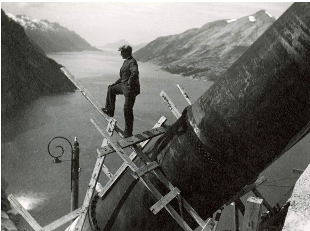
Inspeksjon av rørmontasje.
