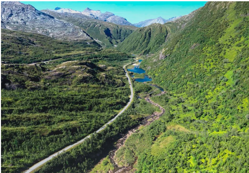
Bilde av Fykanåga mellom tunnel 1 og 3. Foto: Statkraft
