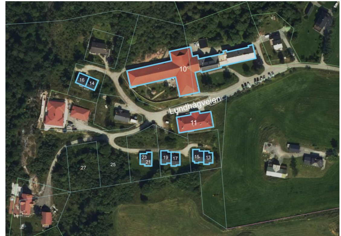
Vall Sykehjem, Vall omsorgsboliger og Vall kommunale boliger i Lundhågveien
