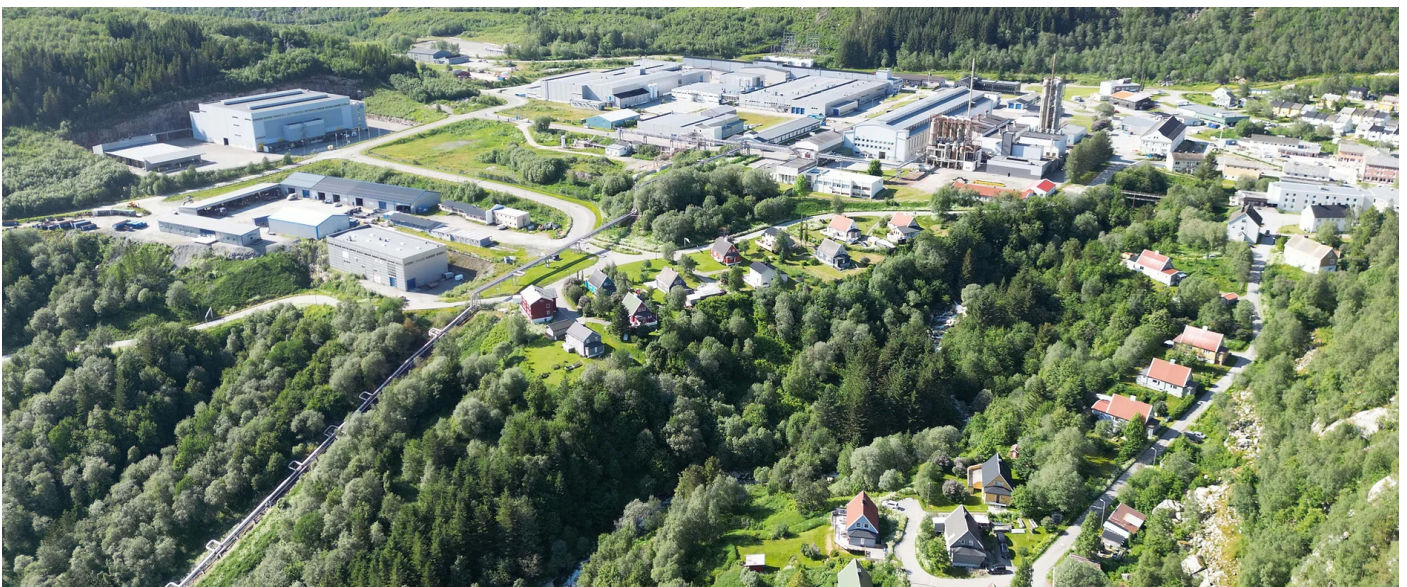
Glomfjord Industripark. Foto: gip.no
